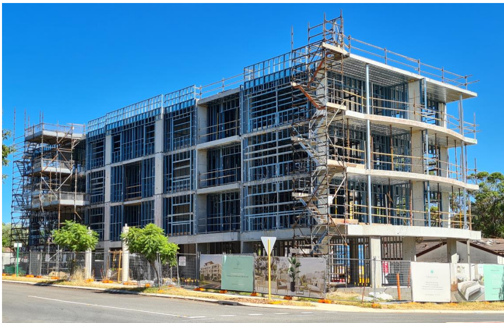
19 Clydesdale Street, Como under construction
